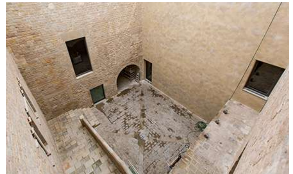
Palau Berenguer d'Aguilar. Rehabilitació dels patis del Museu Picasso executada per Recop restauracions. Fotografia: Monica Moreno
